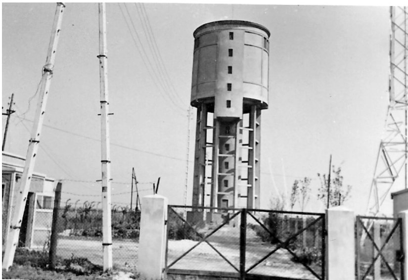
Rys. Wieża ciśnienia
